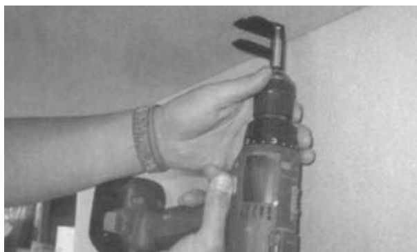
1 Pose au plafond
