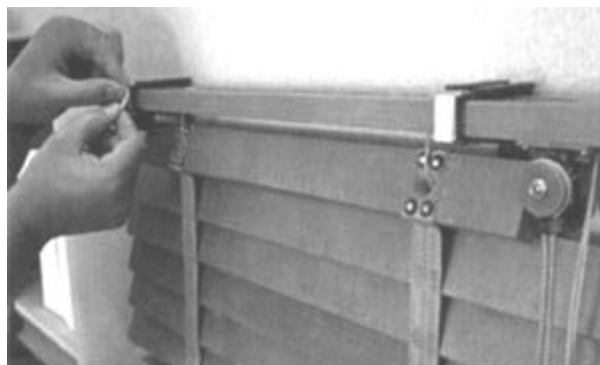
4 Placer les clips et les bandes adhésives sur l'avant des supports
